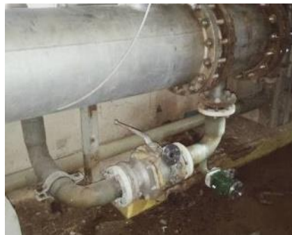
Modify ทำการติดตั้ง line drain Complete
