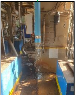
จุด Drain อาคาร ชั้น G ที่ CIO2 Dilute ไหลลงไป
